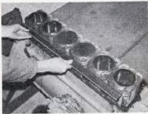
Alignement des cylindres à l'aide d'une règle.
