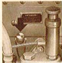
1. Comprobar nivel de aceite en bomba inyección.
