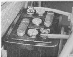
Fig. 26. Kontroll av batteriet.
